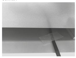
Klebeband an dem Gegenzug Gurten lösen und Fixierung auf dem Behang entfernen.
